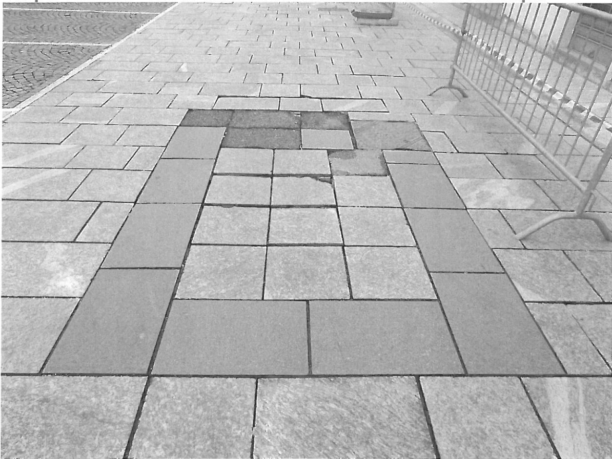
Via per Modena – pavimentazione antistante il Municipio
